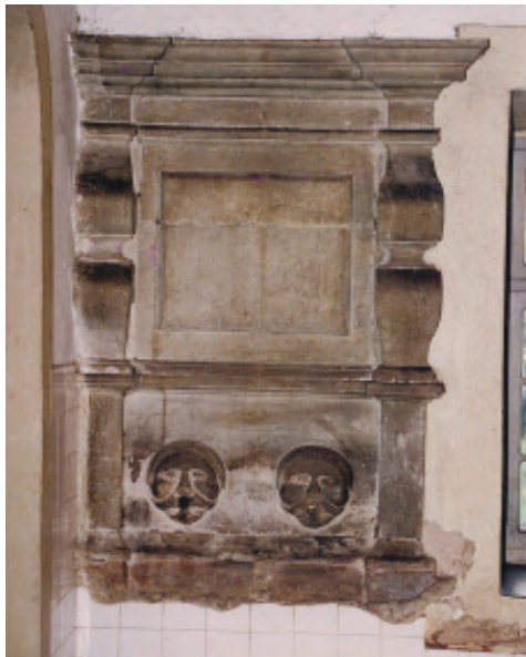
Figura 6: Lavabo do refeitório do convento de São Francisco Foto: Humberto Rocha
