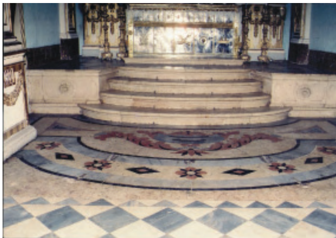
Figura 10: Pavimento diante da capela-mor na igreja da Ordem Terceira de São Francisco Foto: Humberto Rocha
