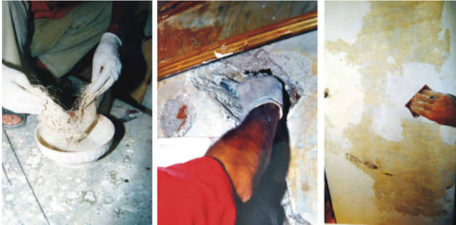
Figura 2: Fases do preenchimento de uma lacuna em um paramento de alvenaria de pedra, estucado com cal e pó de mármore Fonte: Instituto Português, Roma, Itália
