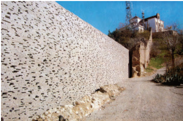
Figura 7: Vista general de la reconstrucción de la muralla nazarí de Granada Foto: Autora
