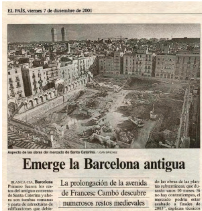
Figura 10: Demolición y vaciamiento del edificio original del Mercat de Santa Caterina y aparición de los restos arqueológicos Fuente: El País , 7 diciembre de 2001
