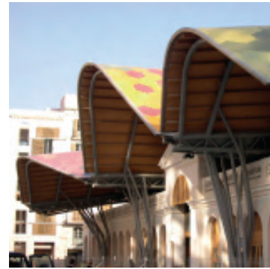
Figura 12: Detalle del voladizo de la cubierta sobre el muro perimetral del mercado original. Estado actual Foto: Autora
