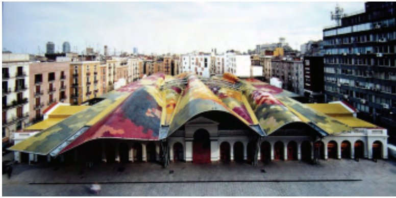
Figura 11: Vista general del nuevo Mercat de Santa Caterina Foto: Revista On Disseny , n. 276, 2006
