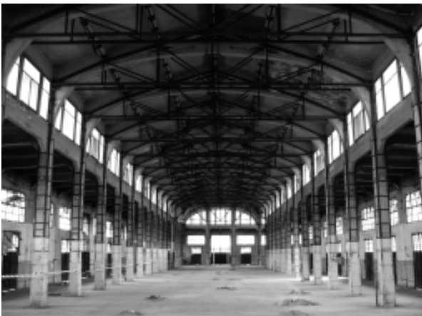
Fig. 4: Mercados Gerais. Antigo pavilhão para venda de carnes e ovos. Edifício n. 2 na implantação da figura 3. Foto: Autora, 2006.
