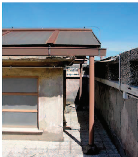
Fig. 12: O lanternim da biblioteca, com a estrutura metálica e vidro, que se apoia sobre a abóbada de vitrocimento. Foto: S Salvo 2012.
