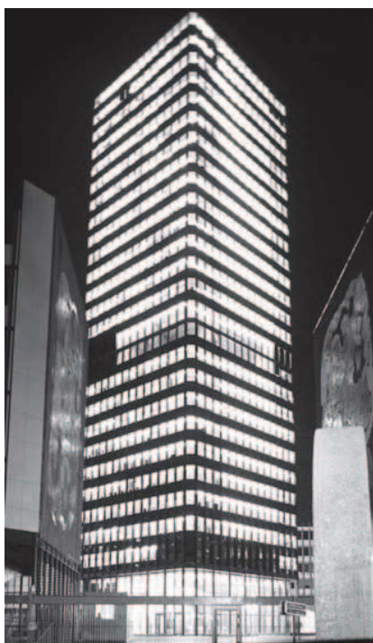
Figura 13: Paris, Centro Universitário Jussieu, 1964-1972, arquiteto Edouard Albert. Torre Zamansky, reabilitada em 2009 pelo arquiteto Thierry Van de Wyngaert. Foto: G. Monnier, 2009
