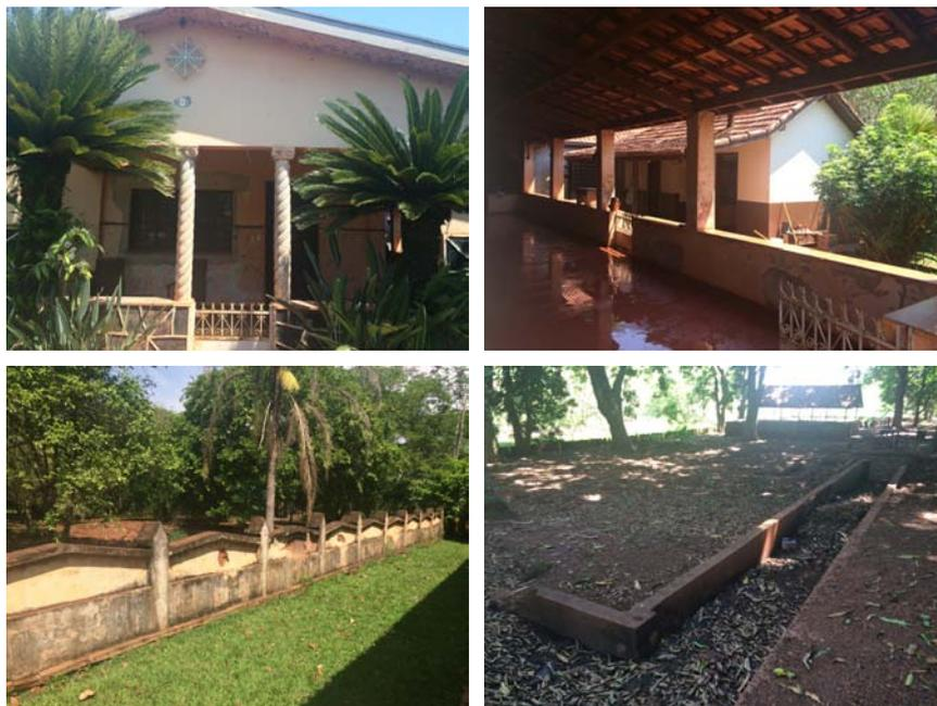
A construção é cercada por uma mureta de concreto com pilares, implantada em um amplo terreno, que remete ao estilo Neocolonial. Sua volumetria é em forma retangular, com embasamento em soco, entrada principal com duas pilastras torcidas, um portão em ferro e acima, no seu tímpano, uma moldura em relevo em forma geométrica com um azulejo e gradil em ferro ornamentado, uma característica do estilo *Art Nouveau*.
