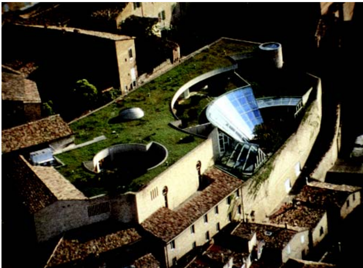
Foto 1: Edifício do Magistério da Universidade de Urbino
