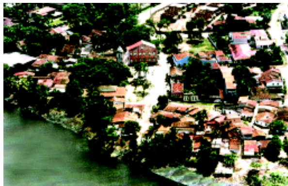
Figura 9 – Largo da Igreja de N. Sa. da Saúde e Estrada Real do Poço da Panela
