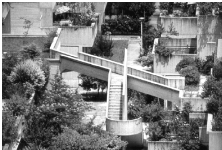
Foto 2: Passarelas para pedestres em Vila Matteotti Crédito: ZUCCHI, Benedict. Giancarlo de Carlo . Londres: Butterworth Architecture, 1992
