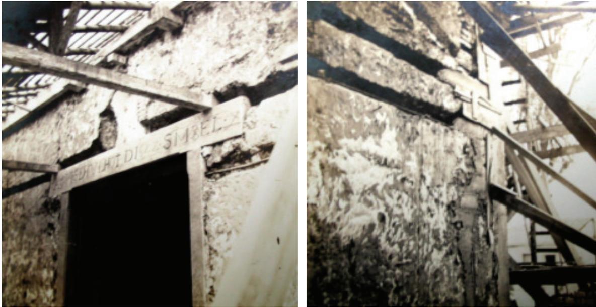
Figuras 10 e 11: Abertura de rasgos na taipa para inserção do concreto
