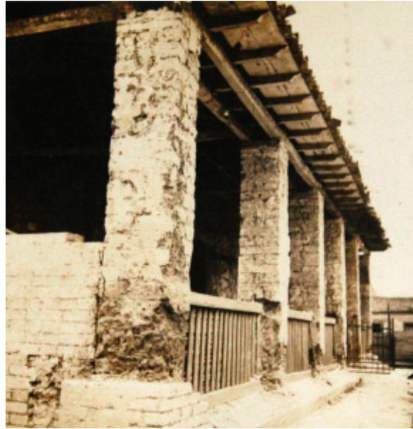
Figuras 4 e 5: Vista lateral e alpendre frontal sem a camada externa de revestimento, evidenciando a técnica de alvenaria de tijolos. Observar ainda os balaústres em madeira nos vãos de janela
