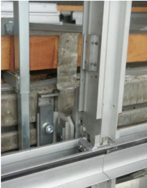
Junta de ancoragem e montantes da fachada contínua, na face exterior da laje de concreto armado, remontados depois do tratamento de reanodização e restauro
