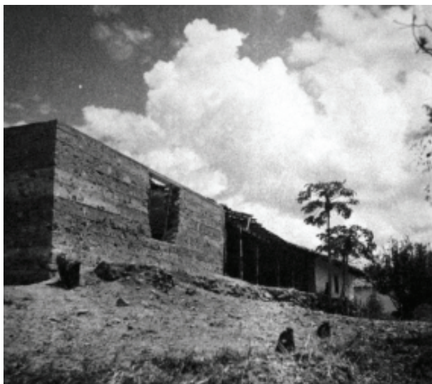
Figuras 11 e 12: Execução da ala esquerda da sede em concreto ciclópico Fonte: Iphan 9ª SR/SP
