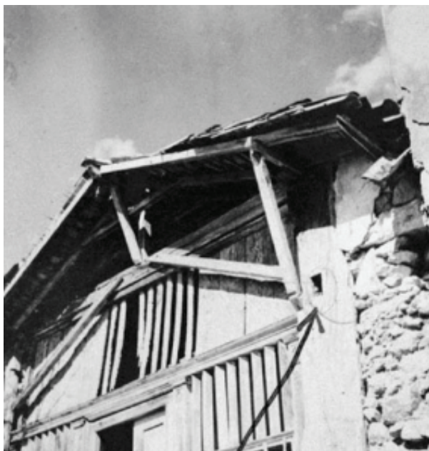
Figuras 8 e 9: A foto à esquerda indica, com seta, a marca retangular do frechal do alpendre da capela. Comparar a solução encontrada – os “pranchões” do fechamento superior citados por Lucio Costa – com a treliça executada Fonte: Iphan 9ª SR/SP
