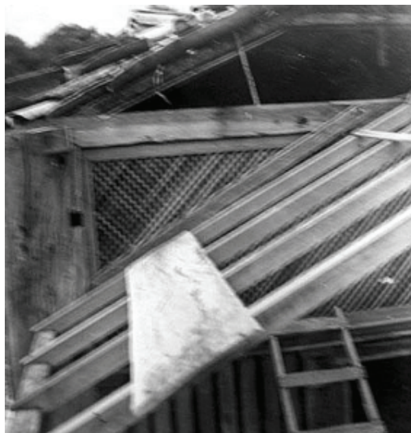
Figuras 8 e 9: A foto à esquerda indica, com seta, a marca retangular do frechal do alpendre da capela. Comparar a solução encontrada – os “pranchões” do fechamento superior citados por Lucio Costa – com a treliça executada Fonte: Iphan 9ª SR/SP
