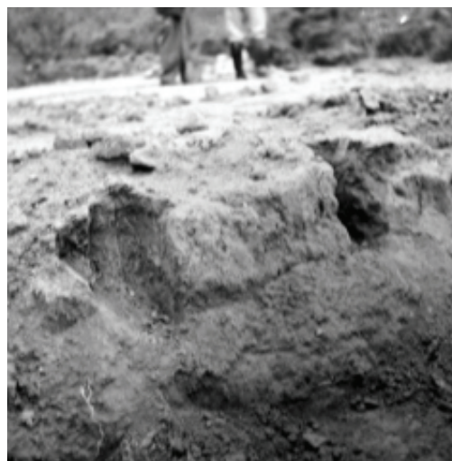
Figuras 5 e 6: Início dos serviços de demolição da taipa da "casa do Barão" e registro das prospecções para detectar os vestígios das fundações da ala ruída da sede, 1945-1947 Fonte: Iphan 9ª SR/SP
