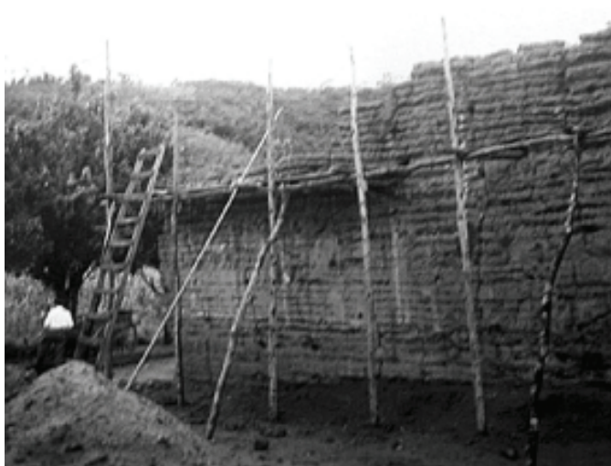
Figuras 5 e 6: Início dos serviços de demolição da taipa da "casa do Barão" e registro das prospecções para detectar os vestígios das fundações da ala ruída da sede, 1945-1947 Fonte: Iphan 9ª SR/SP
