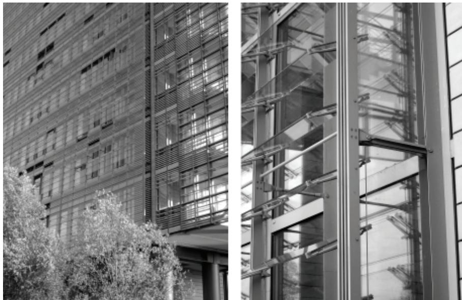
Figura 2: Edifício Debis, em Berlim, Alemanha (1997). Detalhe de uma variante de fachada dupla ventilada em edifícios altos, com a camada exterior passível de abertura (à direita) Crédito: Autora
