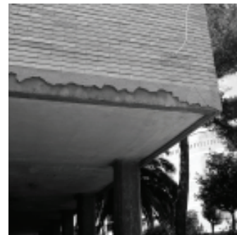
Figura 19: Decima. A degradação se manifestou, principalmente, onde a própria conformação do edifício continha elementos mais expostos à agressão dos agentes atmosféricos
