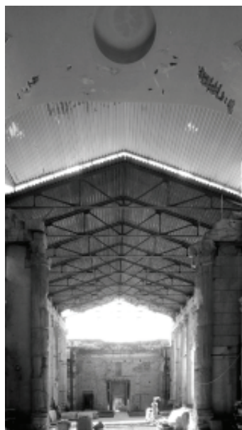
Figura 6: Catedral de Pozzuoli. Interior do edifício, com a cobertura temporária colocada no restauro de De Felice Crédito: Foto de Alessandro Pergoli
