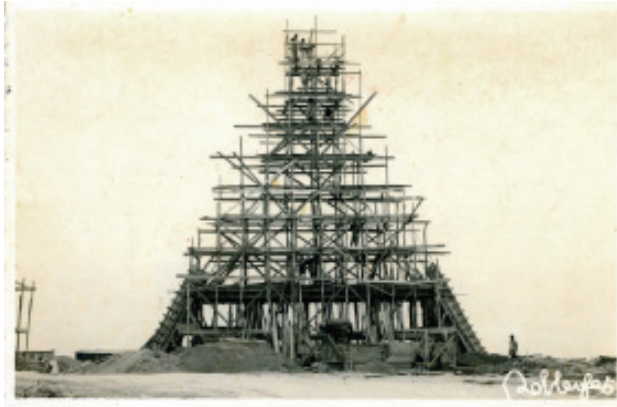
Figura 3: Catedral do Sumbe, Castro Rodrigues, anos 60 Foto: Francisco Castro Rodrigues
