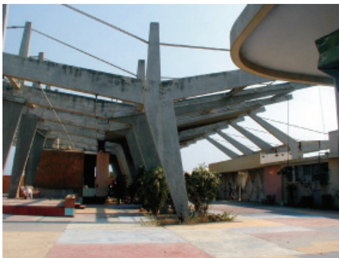
Figura 15: A estrutura “limpa” do Cine Esplanada Flamingo, Lobito, 1964 Foto: Cristina Salvador, 2005
