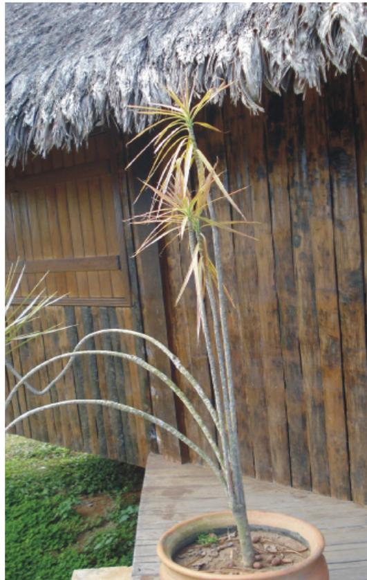
Figura 5: Parede de paxiúba e cobertura de palha
