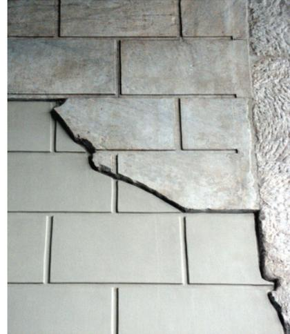
Figura 9: Detalhe da reintegração, em um plano recuado, das paredes antigas
