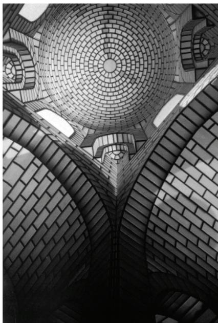
Figura 8: S. Nicolò Regale em Mazara del Vallo, Província de Trapani (Franco Minissi, 1960-1966): pormenor da estrutura proposta para a igreja em malha metálica e “tijolos” de plexiglas. Fonte: Archivio Centrale dello Stato, Fondo Minissi, e. 8, fasc. 109
