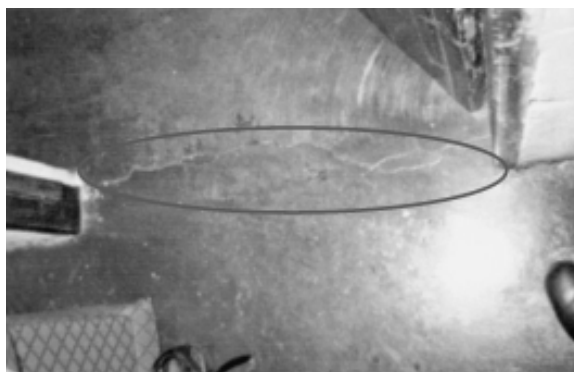
Foto 09 – Habitação ampliada: trincas em piso cimentado, na parte original Crédito: autor
