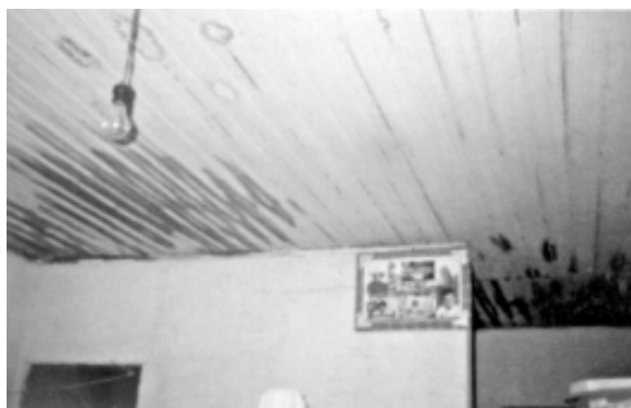
Foto 10 – Habitação ampliada: marcas de infiltrações no forro na parte original, oriundas de infiltrações na cobertura Crédito: autor
