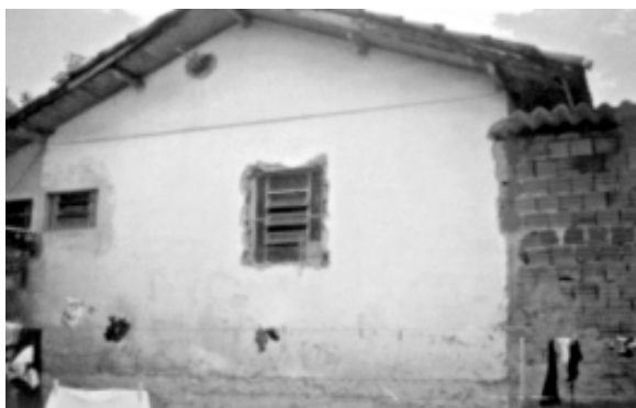
Foto 06 – Habitação ampliada: elevação posterior com destacamento do reboco na base da parede, na parte original Crédito: autor
