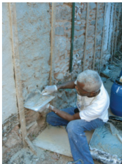
Figura 6: Aplicação de argamassa-teste, grupo A2 Fonte: Arquivo FCRB, por Cláudia Carvalho
