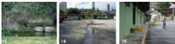
13. Pequena lagoa de aforramento de água aos pés de mato no terreno ocupado pela Unidade de Armazenamento de Obras 14. Escoamento superficial permanente na área do antigo brejo 15. Degraus para evitar que as águas das enchentes invadam os edifícios da Unidade de Armazenamento 16. Tampa da caixa de inspeção da galeria, encoberta por areia, marca o trajeto do córrego no terreno da Unidade de Armazenamento 17. Bocas de lobo na rua Laudelino Vieira de Campos sinalizam encontro dos córregos 18. Galeria do córrego Pirituba na rua Camarões, a oeste da estrada de ferro
