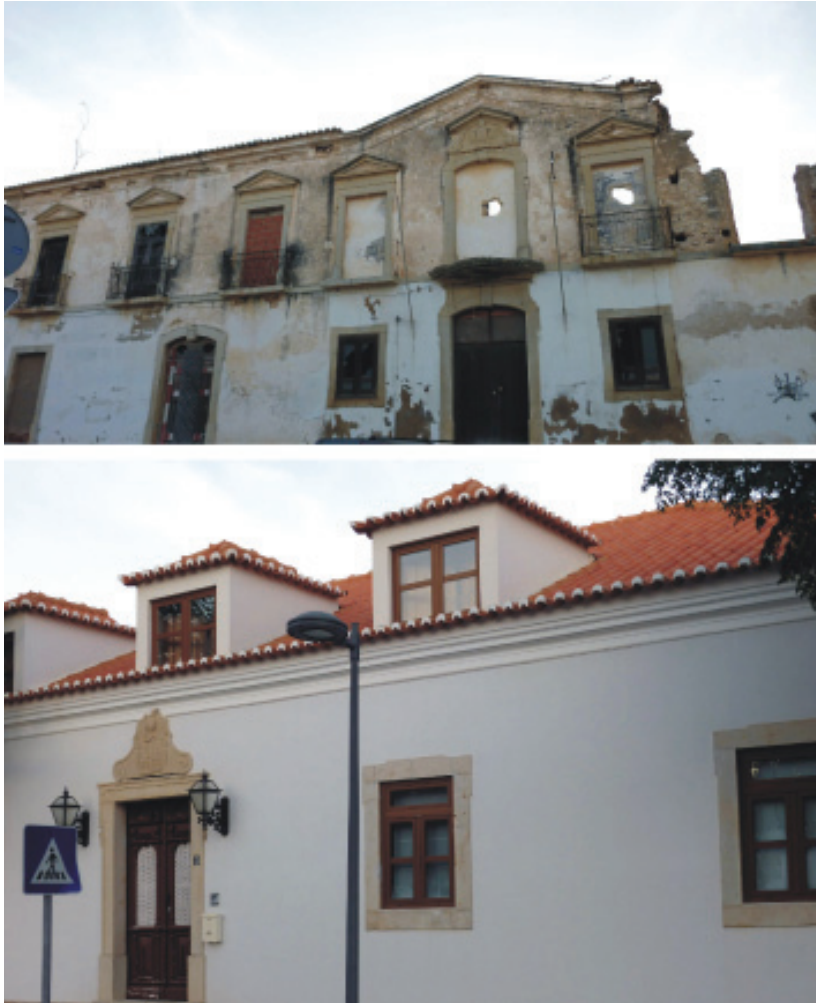
Figura 1: Dois casos de desconhecimento ou não consideração das culturas construtivas tradicionais. Em cima, o abandono, esperando a possibilidade da demolição e da construção com a cultura construtiva dominante. Em baixo, a plastificação de revestimentos, caixilharias, a alteração da volumetria, da leitura da fachada, em uma aplicação errônea da cultura construtiva dominante na conservação (Albufeira, Portugal) Fotos: João M. Mateus
