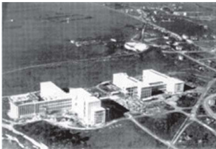
Figura 1: Caen, Universidade, 1948-1954, arquiteto Henri Bernard; vista do canteiro de obras s.d.
