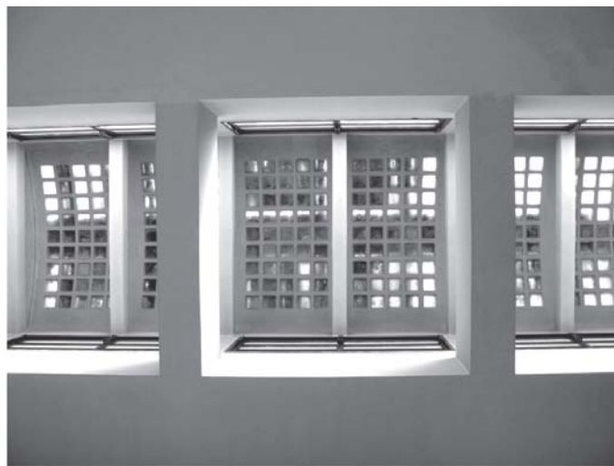
Fig. 5: Lanternim que ilumina a sala de leitura da biblioteca, visto de baixo Foto: S. Salvo.
