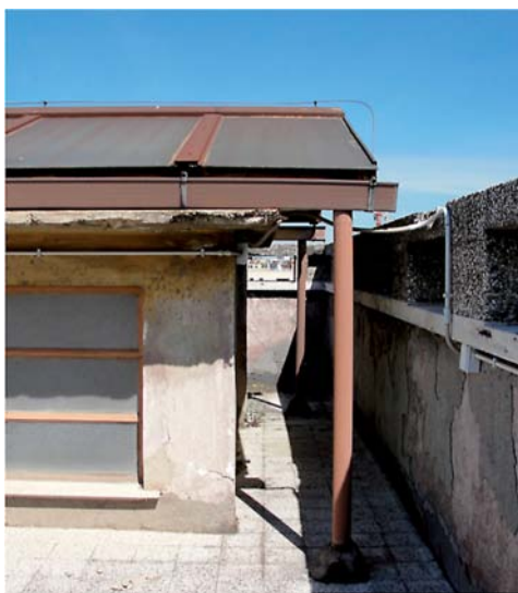
Fig. 12: O lanternim da biblioteca, com a estrutura metálica e vidro, que se apoia sobre a abóbada de vitrocimento
