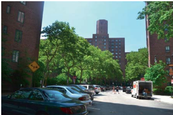
Figura 6: conjunto habitacional público Baruch Houses, Nova Iorque Foto: Eduardo Nobre
