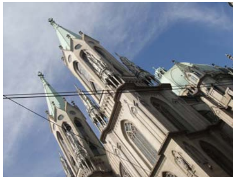
Figura 24: Catedral da Sé com destaque para os torreões e agulhas novos executados segundo projeto original. Fonte: Foto da autora.
