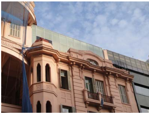
Figura 7: Casa de Cultura Mário Quintana: fachada posterior onde foi incorporada a cobertura em estrutura metálica e vidro. Fonte: Foto da autora.
