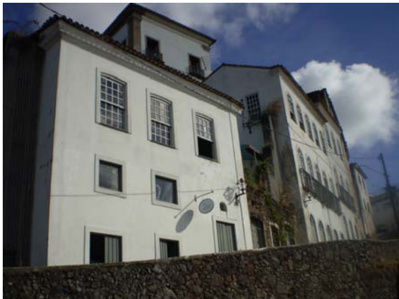
Figura 29: Vista geral do conjunto de Residências da Ladeira da Misericórdia. Fonte: Foto da autora.
