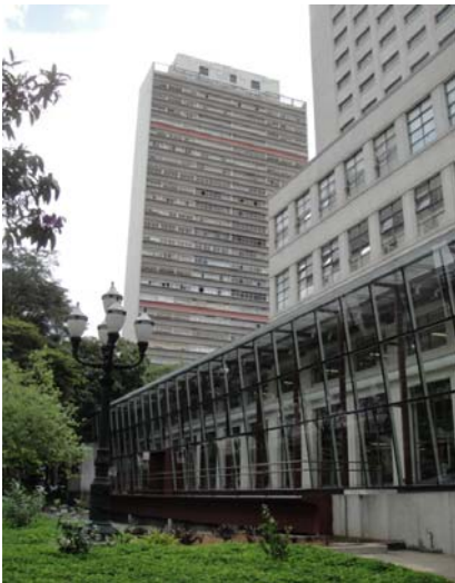
Figura 27: Vista da nova ligação entre as alas da biblioteca. Fonte: Foto da autora.
