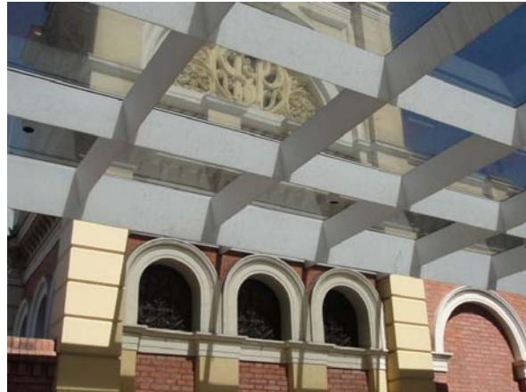
Figura 21: Nova cobertura metálica do Museu da Língua Portuguesa, na entrada da Estação da Luz. Fonte: Foto da autora.
