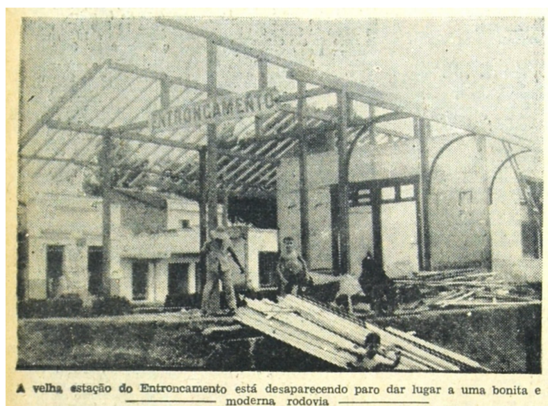
Figura 5 Desmontagem da Estação Ferroviária do Entroncamento (Belém)
