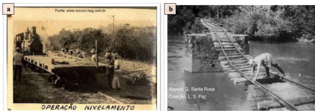
Figura 3 (a) Operação de nivelamento da Estrada de Ferro Tocantins, s/d; (b) implantação de trilhos na EFT em região aquática, s/d
