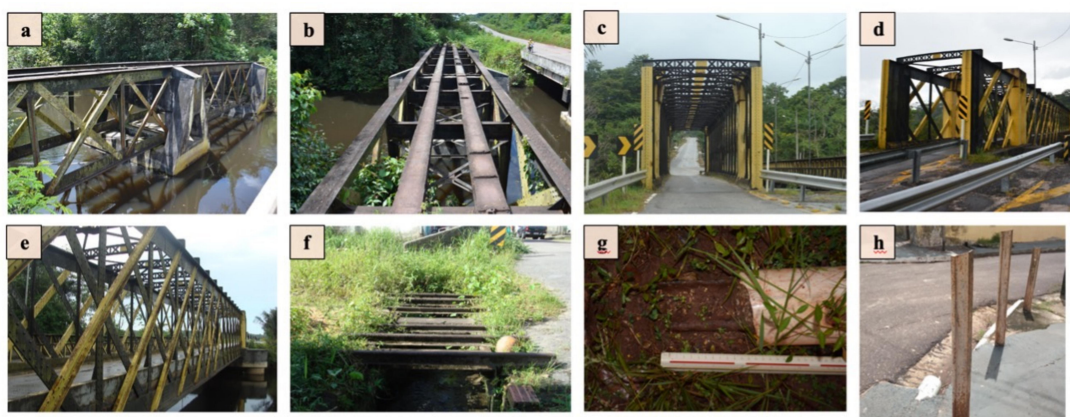
Figura 13 (a, b) ponte metálica de Jambu-Açú em São Francisco do Pará; (c,d,e) vistas da ponte metálica do Livramento em Igarapé-Açú; (f) composição de trilhos em Bragança às margens do rio Cerejo; (g) trilhos utilizados como suporte para varal de roupas na colônia de Santo Antônio do Prata (Igarapé-Açú); (h) trilhos utilizados como cercado em Santa Izabel do Pará
