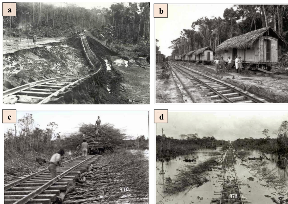
Figura 4 (a) Deslizamento de trilhos causados pela chuva, 1909-1910; (b) acampamento de trabalhadores às margens da via férrea, 1909-1910; (c) assentamento de trilhos em região de desmatamento, 1909-1910; (d) temporada de cheia no rio Madeira, 1909-1910
