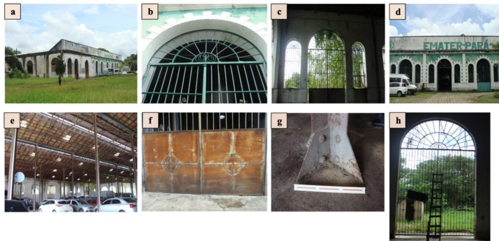
Figura 9 Instalações da antiga oficina da EFB em Marituba, atualmente sedia o depósito de carros da Empresa de Assistência Técnica e Extensão Rural do Estado do Pará (EMATER-PA). (a) vista parcial da fachada do prédio; (b) detalhes de grades e bandeira; (c) grades e portão; (d) vista parcial da fachada do prédio; (e) interior do prédio, detalhes de vigas, tesouras e colunas em metal; (f) lâminas de portão; (g) detalhes da base de coluna; (h) portão e bandeira
