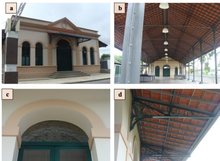
Figura 8 Antiga estação ferroviária de Icoaraci, atual centro cultural. (a) vista da fachada; (b) vista das estruturas metálicas como vigas, tesouras e colunas no interior do edifício; (c) detalhe de bandeira em metal no prédio; (d) vista de mão francesa em metal
