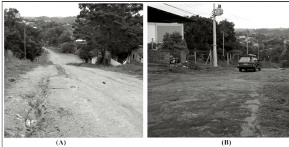
Figura 4 (A) - Ravina sobre arruamento no setor de média e baixa vertente da colina; (B) - Arruamento precariamente pavimentado sobre setor de alta vertente da colina.
