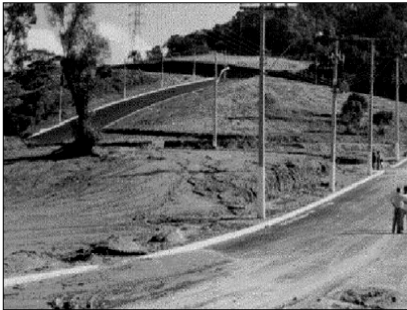
Figura 3 Sedimentos transportados por escoamento superficial sobre arruamento. Fonte: METROPLAN, 2001
