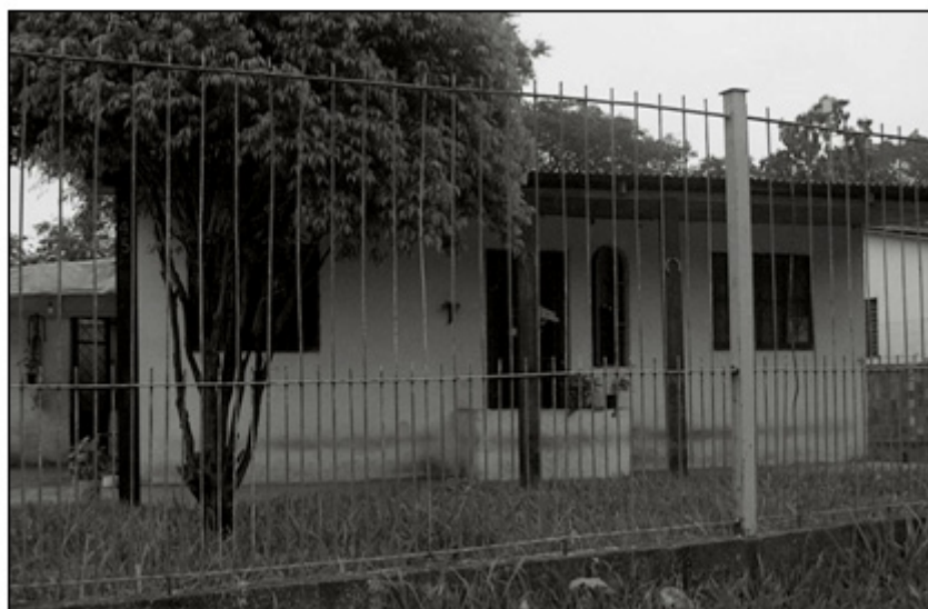
Figura 9 Evidências da variação da lâmina d'água do arroio Domeles, junto a domicílio, resultantes de inundações Fonte: REHBEIN, 2005
