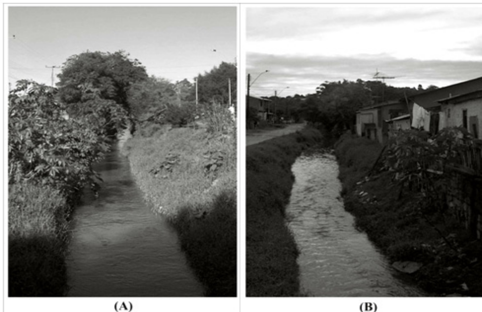
Figura 5 Seções retificadas e periodicamente dragadas do arroio Dornelinhos. Fonte: REHBEIN, 2005
