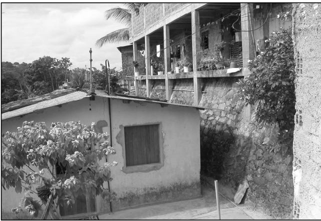
Figura 5 Exemplo da intensa ocupação e verticalização do talude impermeabilizado.
