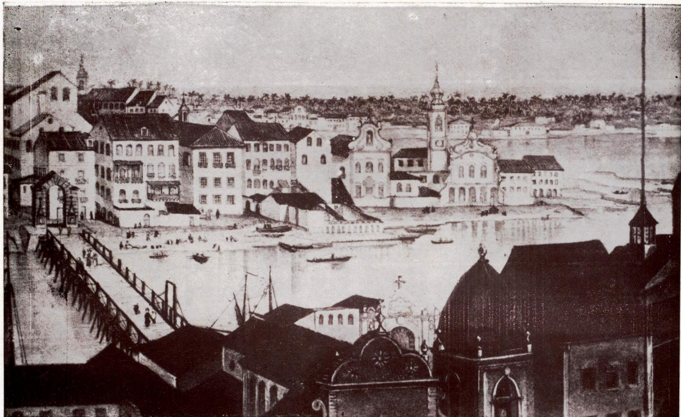
Recife na primeira metade do século XIX. Vê-se um trecho do bairro de Santo Antônio com a ponte, hoje, Maurício de Nassau e um dos arcos, justamente o de Santo Antônio.
