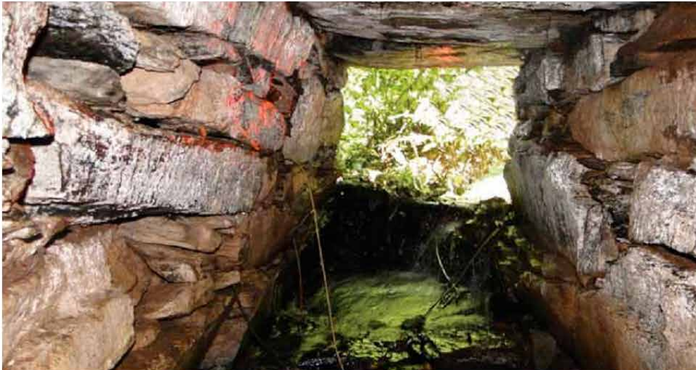
Figura 05. Foto tirada de dentro do duto de pedra. Duto de 96 metros de extensão, encontrado na porção nordeste de Guarulhos. Fonte: acervo próprio, 2010.
