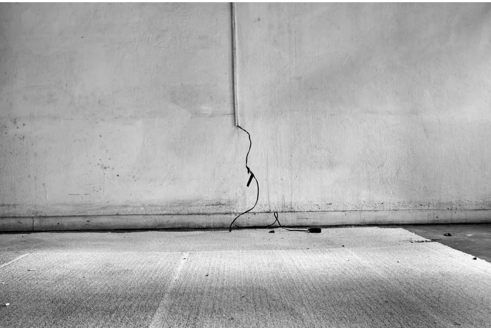
Figura 1: Vista Pro Mar #1. Foto: Ilana Bessler
