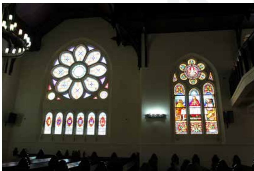
Figura 9: Vista interna da parede que foi totalmente destruída. Fonte: Autora.
