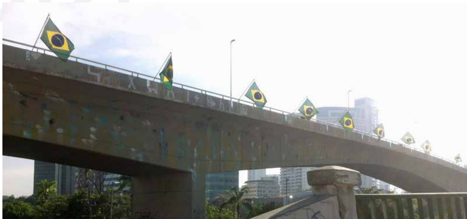
Figura 8: Bandeiras do Brasil instaladas ao longo da ponte Bernardo Goldfarb vista a partir da ponte Eusébio Matoso. Foto: Amanda Saba Ruggiero.
