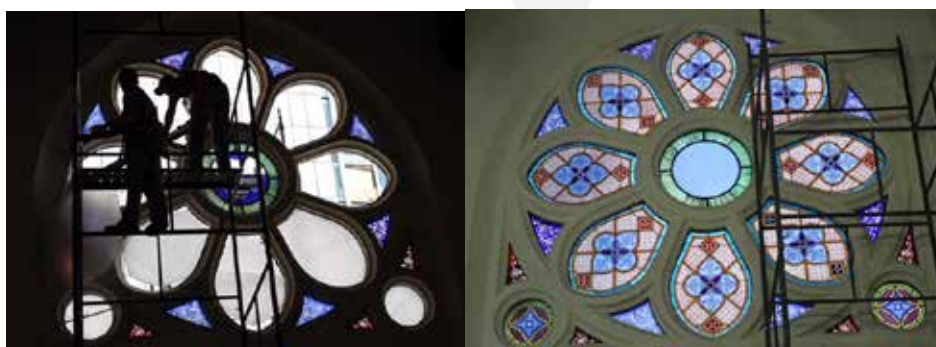
Figura 5 e 6 : A Grande Rosácea sendo parcialmente retirada, com o vidro central partido e substituído. Fonte: Autora.
