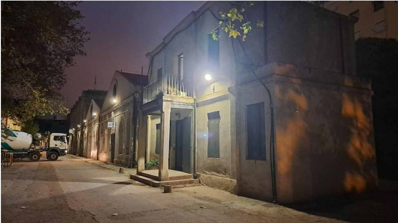
Figura 5: Foto noturna da fachada, o caminhão betoneira a esquerda mostra o trabalho ininterrupto das construtoras ao lado do Hangar, quase soterrando o que resta da antiga fábrica.
