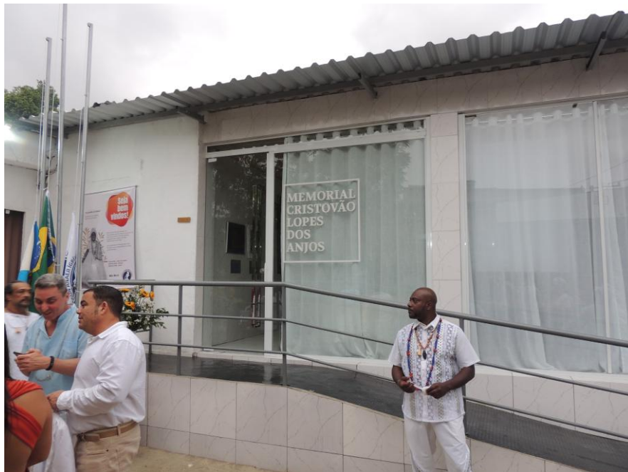
Figura 5: Corrimão, piso tátil e rampa de acesso no Memorial. Fonte: Acervo Pessoal - Caio Victorino.
