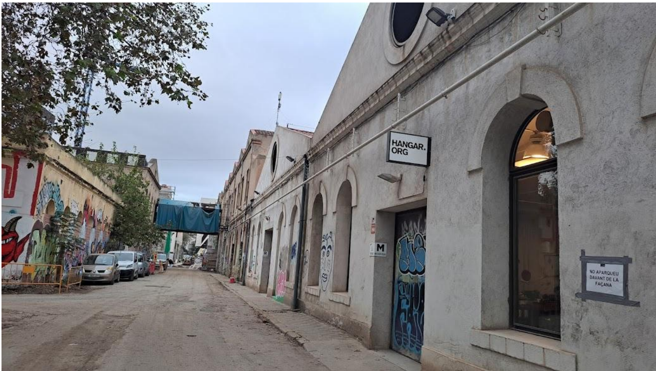
Figura 2: Foto da entrada do Hangar, com a fachada preservada da antiga fábrica, e lado esquerdo da imagem, canteiro de obra de novos edifícios em construção.
