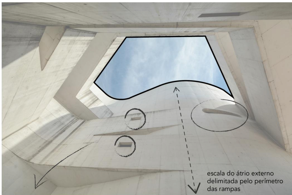
Janelas das rampas com visuais emolduradas pelas rampas externas ao edifício.
