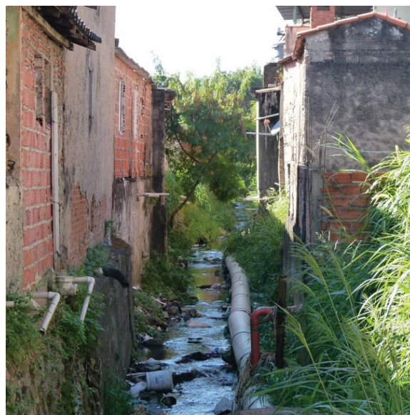
Figura 34 – Córrego da Água Fria visto da R. Francisco Pecoraro em direção à Av. Água Fria. Fonte: Imagem das autoras, 2016.
