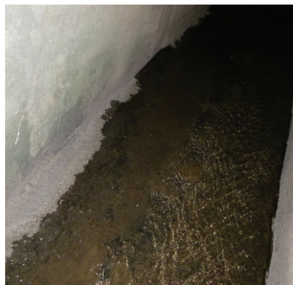
Figura 24 – O córrego aprisionado. Fonte: Imagem das autoras, 2016.
