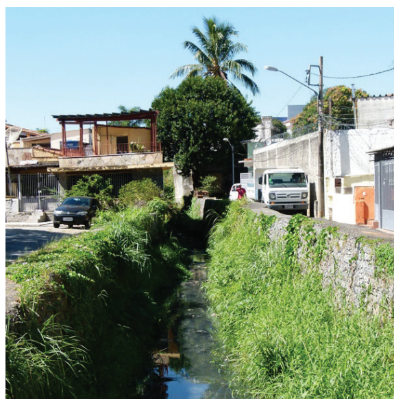
Figura 21 – Córrego entre muros de pedra ao lado da Praça Rufus King Lane. Fonte: Imagem das autoras, 2016.
