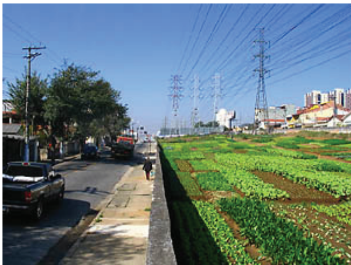
Figura 8 – Horta implantada sob linhas de alta tensão na cidade de São Bernardo do Campo. Fonte: O Eco, jornalismo ambiental.
