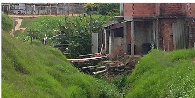
Figura 5 – Esgoto lançado no afluente do Ribeirão Cocaia por meio de ligações clandestinas.
