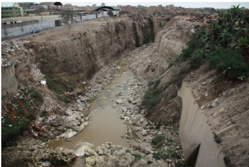
Figura 05 – rio Rímac com área de despejo de lixo e assentamentos que causam o deslizamento das margens. Fonte: Andino, 2015
