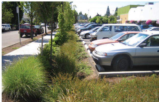
FIGURA 6. Biovaleta do estacionamento do New Seasons Market em Portland. Fonte: CORMIER, PELLEGRINO, 2008.
