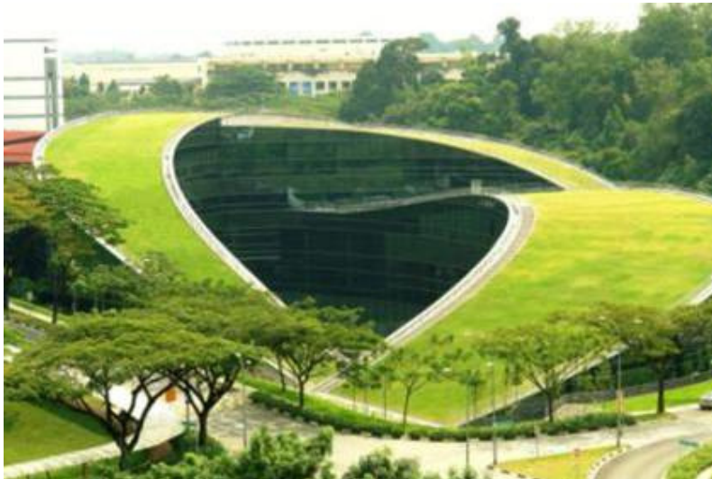
FIGURA 8. Telhado verde. Fonte: ANANDASIVAM, CHEONG, 2008.
