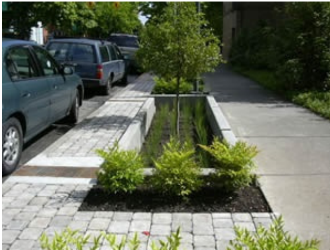
FIGURA 5. Canteiro pluvial em Portland. Fonte: Environmental Service, 2018
