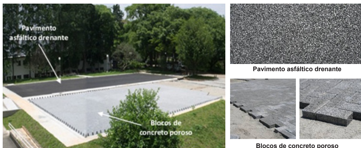
FIGURA 10. Exemplo de pavimentos permeáveis em estacionamento Fonte: (VIRGILIIS, 2009).
