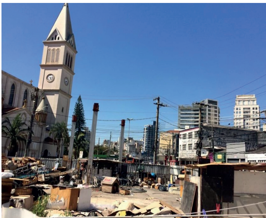
FIGURA 8. Largo das Araucárias antes da reforma: local de despejo de entulho. Fonte: CARDIM PAISAGISMO, s./d.
