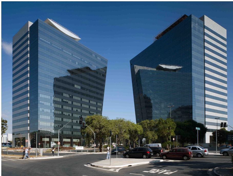
Fig. 2 – Edifícios Rochaverá vistos no nível do pedestre.
