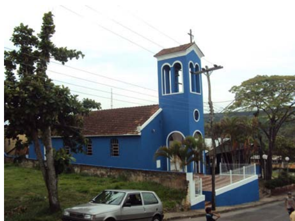
Figura 6: Igreja Nossa Senhora Aparecida. Foto: ELIANA HOSOKAWA 2011
