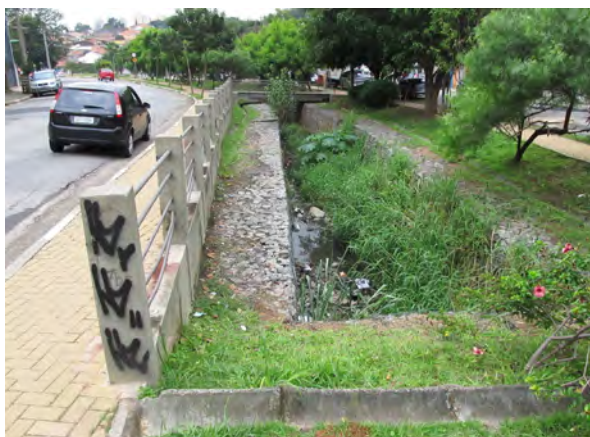
Figuras 10: o rio delimitado com gabiões, no Parque Linear do Sapé. Fonte: visita no dia 15/05/2012.
