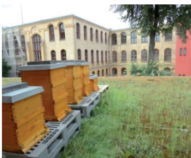
Telhado Verde Extensivo, Refeitório Universitário HU, Berlim 2011
