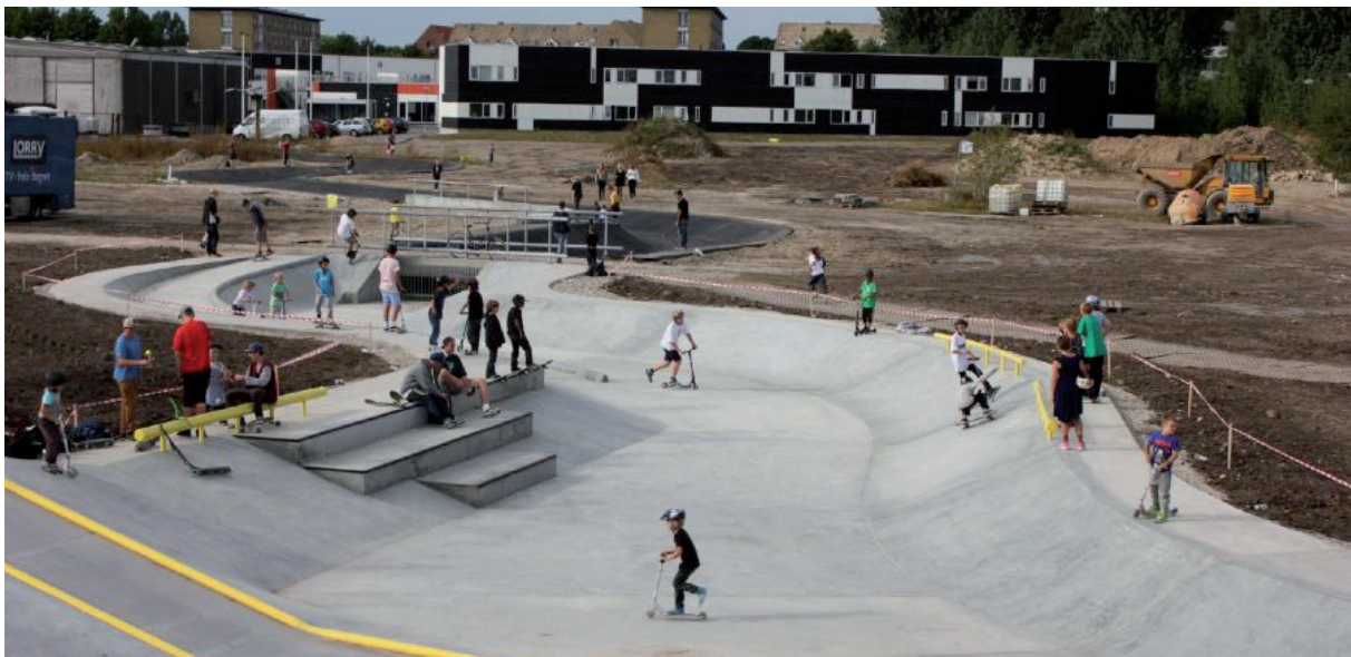
Figura 3: Parque Rebalder, na Dinamarca – espaço multifuncional: drenagem e recreação. Fonte: disponível em < http://inhabitat.com/denmarks-rabalder-park-can-contain-10-swimming-pools-worth-of-floodwater/rabalder-parken-2/?extend=1 >. Acesso em 29 nov 2013
