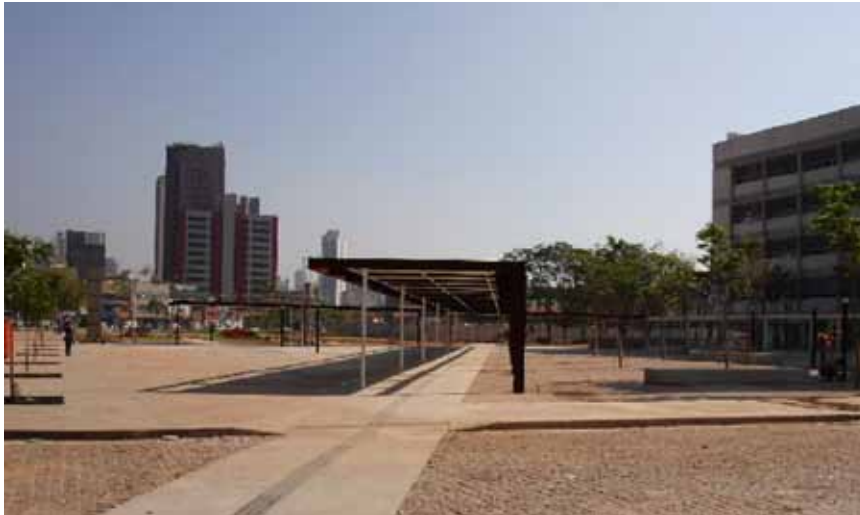
Figura 3 – Parque Institucional - Bloco reformado do Carandiru e Pergolado da Alameda central
