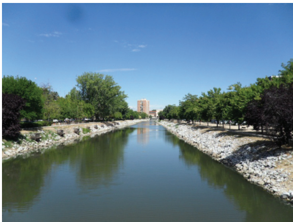
Figura 25 – margens modeladas com revestimento de pedra ao longo do rio Manzanares, em San Antonio de La Florida, em Madrid, 2014 (esquerda). Fonte: Arquivo MARF
