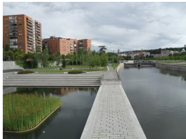
Figura 26 – equipamentos de infraestrutura verde ao longo do Parque linear Manzanares, próximo à Ponte de Segóvia, em Madrid, 2014 (direita). Fonte: Arquivo MARF
