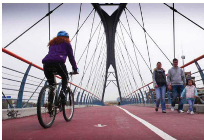
Figura 28 – Passarela com ciclovía e calçada de pedestres (direita).
