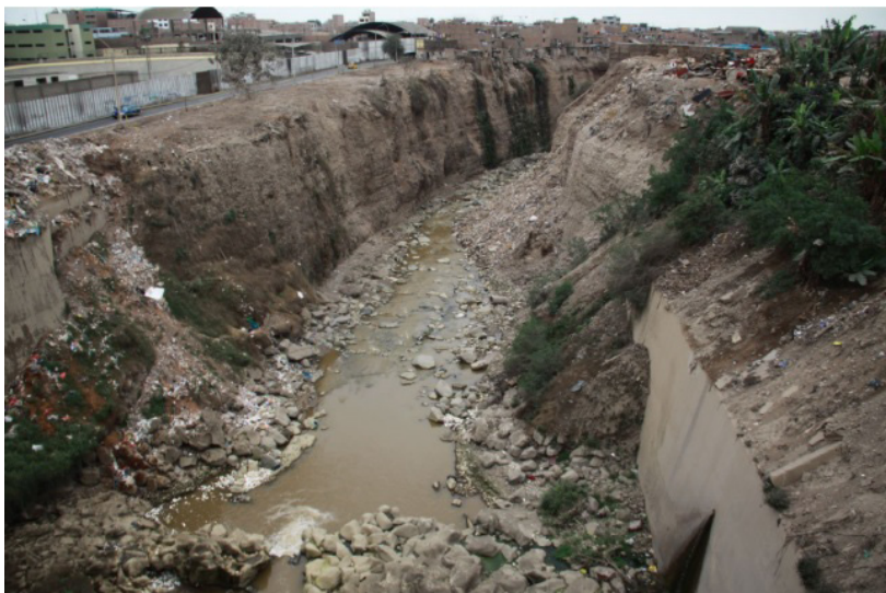
Figura 05 – rio Rímac com área de despejo de lixo e assentamentos que causam o deslizamento das margens. Fonte: Andino, 2015
