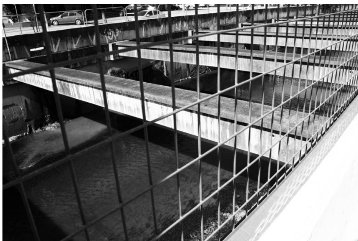
Figura 6 – Vigamento sobre calha concretada do Córrego Mandaquí (foto do autor)
