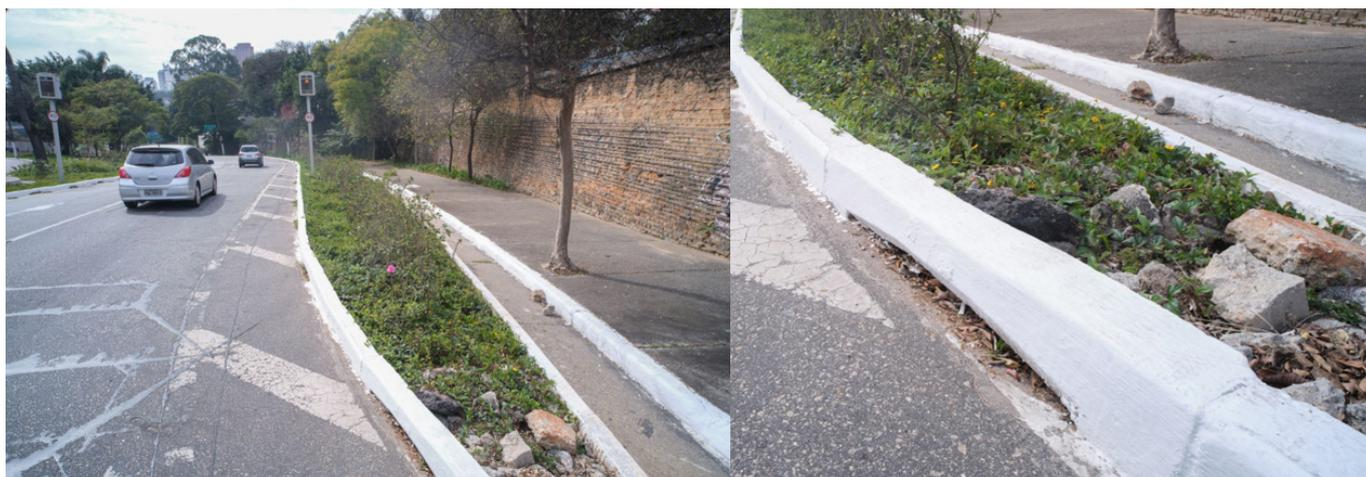
**FIGURA 14.** Visão geral de jardim de chuva no Pacaembú (esquerda) e entradas de água com guias padrão PMSP e brita para dissipar energia, no mesmo jardim (direita).
