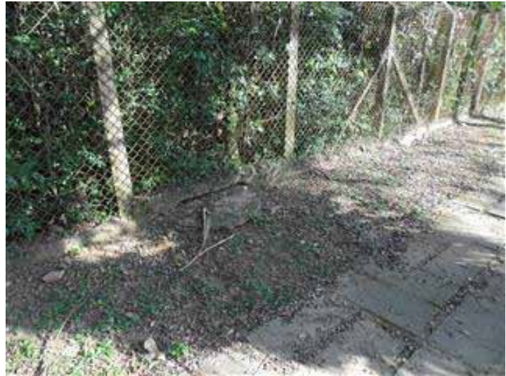
Figura 14 – Bueiro sob gradil da Reserva Florestal: seria o lago a origem do córrego da FAU? Foto do autor.
