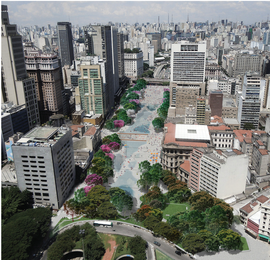
Vale do Anhangabaú: lugar estratégico para a renovação do centro da cidade de São Paulo. Fonte: SPURBANISMO.
