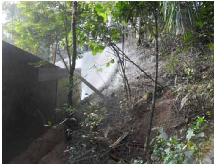
Figura 15 – Erosão provocada pela água e tentativa de eliminá-la. À esquerda, imediações do edifício Semi-Industrial da Poli. À direita, construção de edifício das Ciências Farmacêuticas, na r. do Lago. Fotos do autor.
