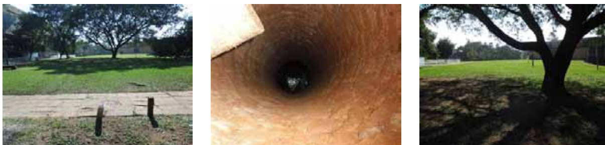
Figura 13 – Aproximações da estrutura arredondada de concreto aos pés de uma árvore entre o edifício Vilanova Artigas e o anexo da FAU. À direita, retirada a tampa que esconde o córrego. Fotos do autor.
