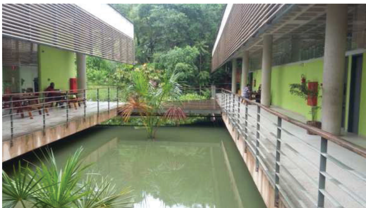
Figura 4 –Vista interna do Edifício do Centro Educativo Burle Marx. Fonte: foto da autora
