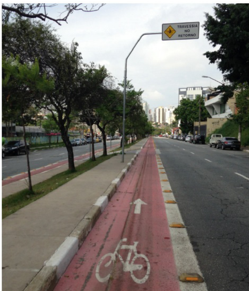
Figura 5 – Sinalização horizontal e Vertical de Ciclovia. Fonte: ITDP. 2015.
