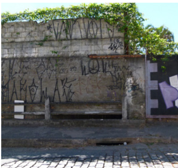
Figura 23 – Guarda-corpo de uma provável ponte indicando um córrego oculto. Fonte: Imagem das autoras, 2016.
