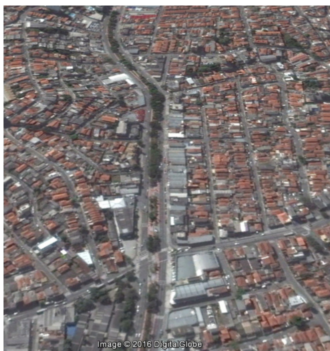
Figura 15 – Avenida Caetano Álvares no cruzamento com a Av. Imirim, na zona Norte de São Paulo. Detalhe para o Ribeirão do Mandaqui, canalizado e tamponado. Fonte: Google Earth. Acesso em 23/05/16
