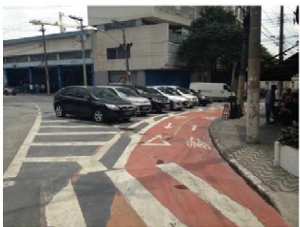
Ciclovia segregada com buffer (canteiro central fictício) e estacionamento de veículos perpendicular R. Rio Bonito, Centro
