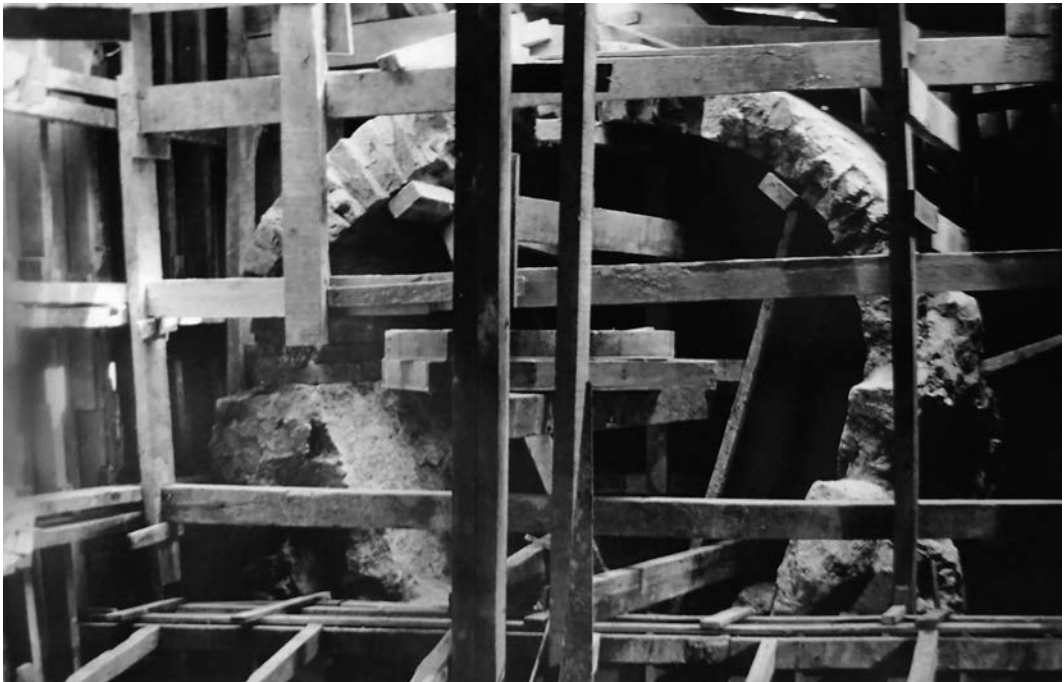
Fig. 13: Obra de canalização do ribeirão do Anhangabaú (século XIX) (Acervo DPH)
