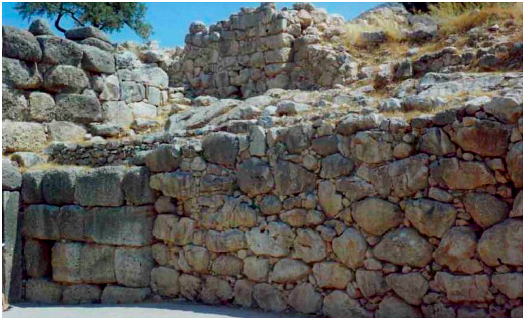
Fig. 4. Alvenaria ciclópica com corte retangular (esquerda) e blocos sem corte retangular com pedras menores conectando os interstícios entre blocos (direita).
