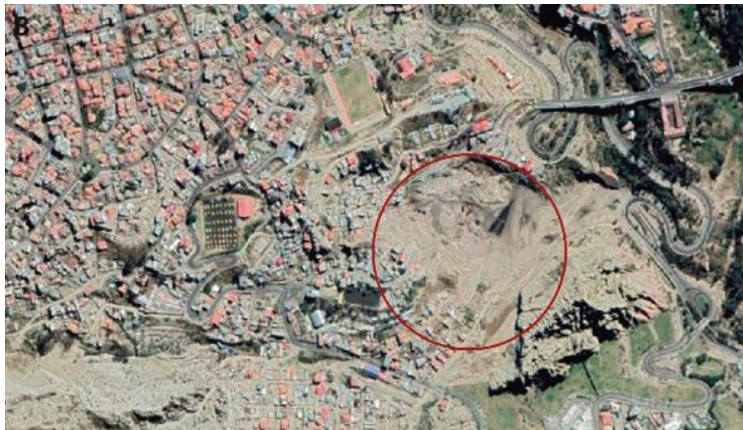
Fig. 8B. La zona de Bajo Llojeta después del deslizamiento de mayo de 2019.
