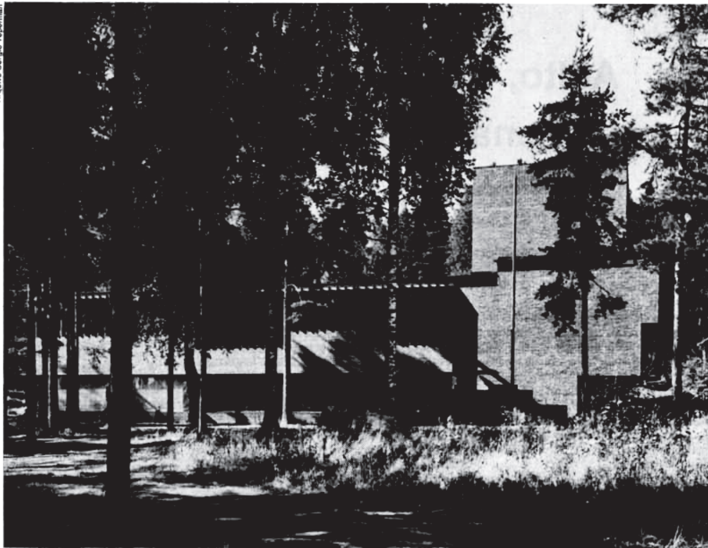
A prefeitura e o centro comunitário de Säynätsäko, pequena aldeia finlandesa projetada por Aalto
