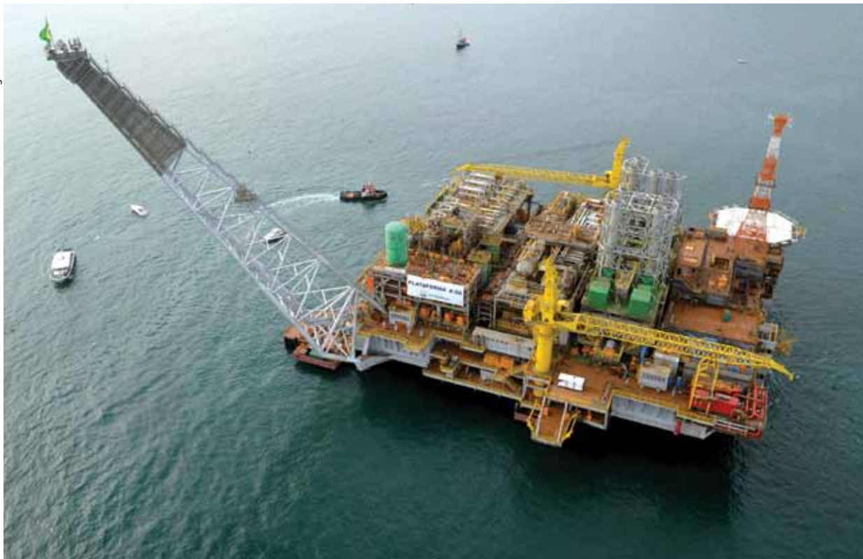
Plataforma P-56, instalada no campo de Marlim Sul, Bacia de Campos
