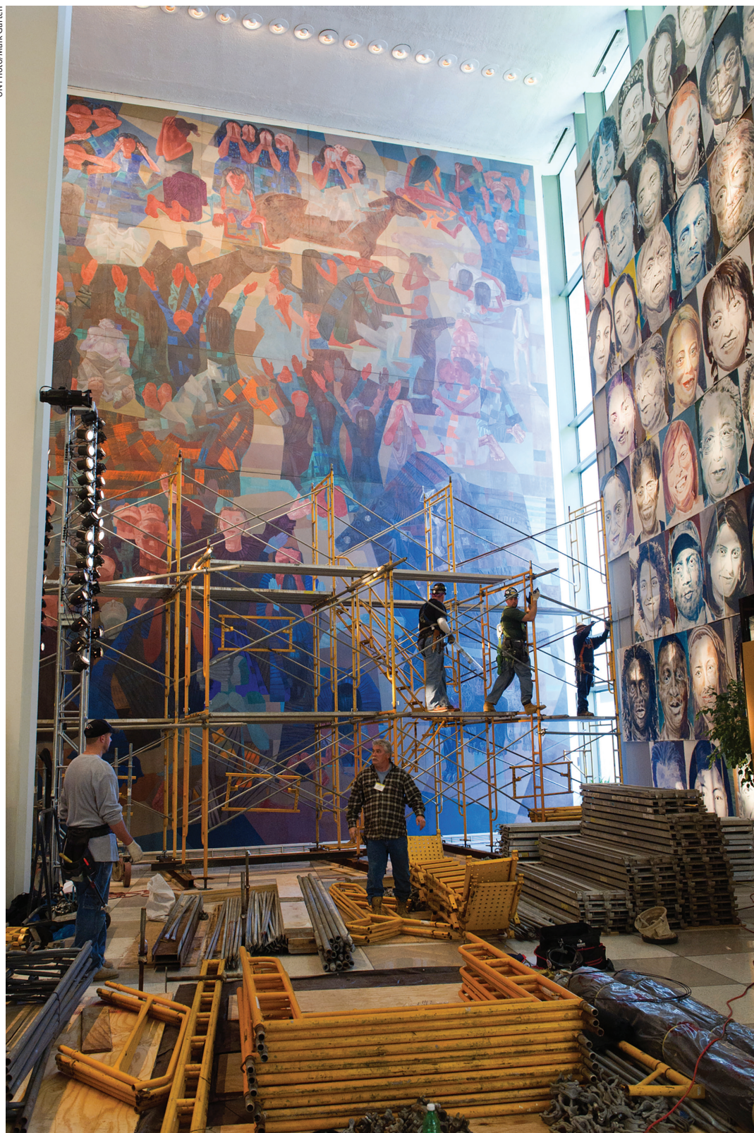
Trabalhadores removem painéis do mural Guerra e paz de Cândido Portinari do prédio da Assembleia Geral da ONU
