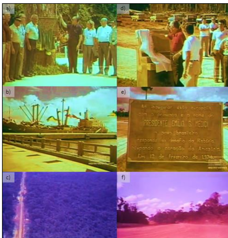
Figura 4. Conclusão das obras na Amazônia
