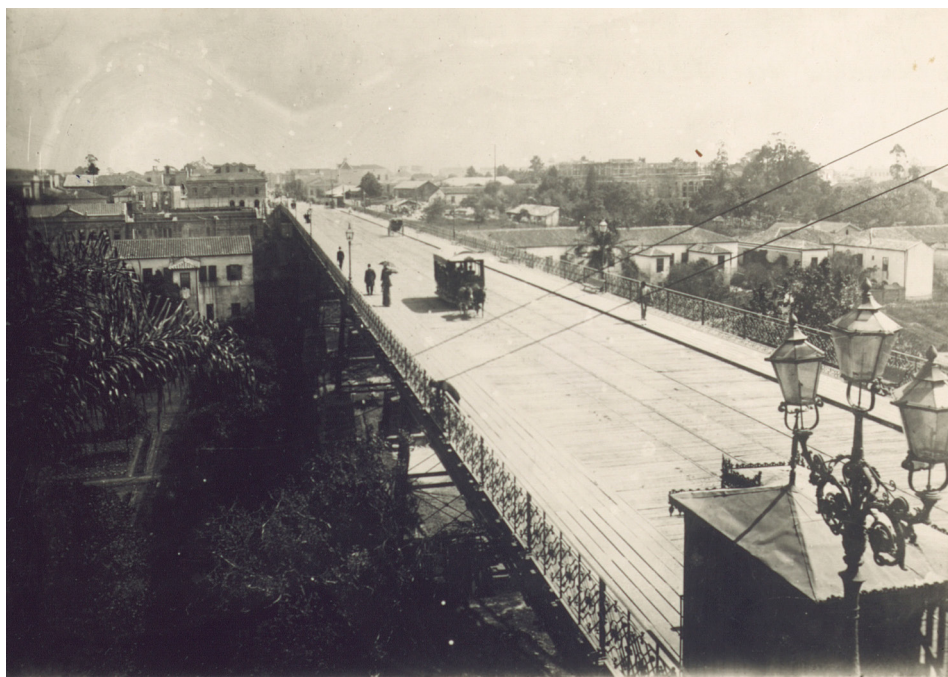
Viaduto do Chá em 1892 e 1893 em direção à Rua Barão de Itapetininga. À direita, ao fundo, início da construção do Theatro Municipal. Arquivo IEB – Acervo Cidade de São Paulo (Ernani Silva Bruno)
